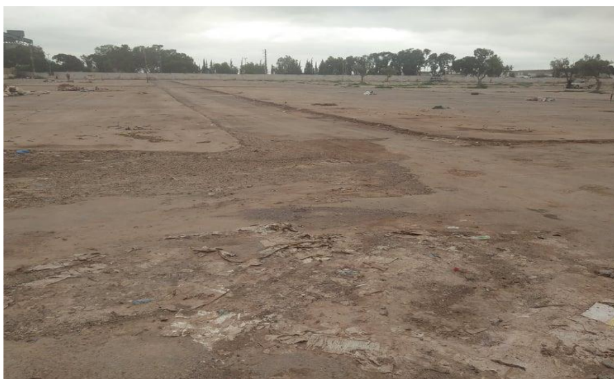
Photo 1-14 : La mauvaise infrastructure du MHR
