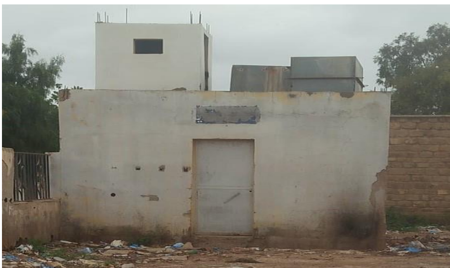
Photo 1-18: Les sanitaires existent réellement mais ne fonctionnent pas
