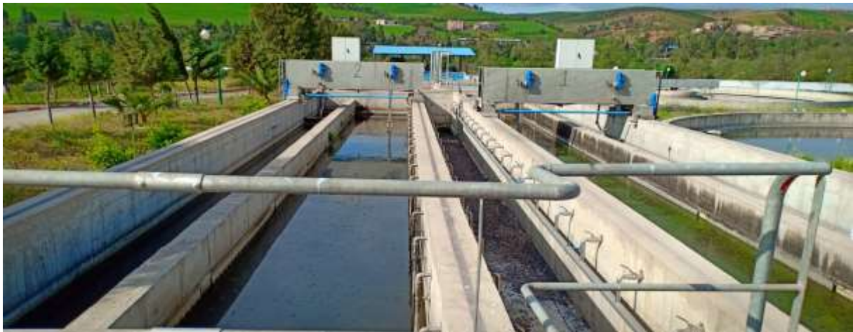
Figure n°09 : Les deux lignes de dessablage/déshuilage
