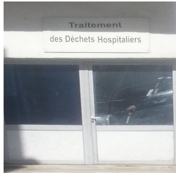
Figure n°29. : Le centre de traitement des DH
